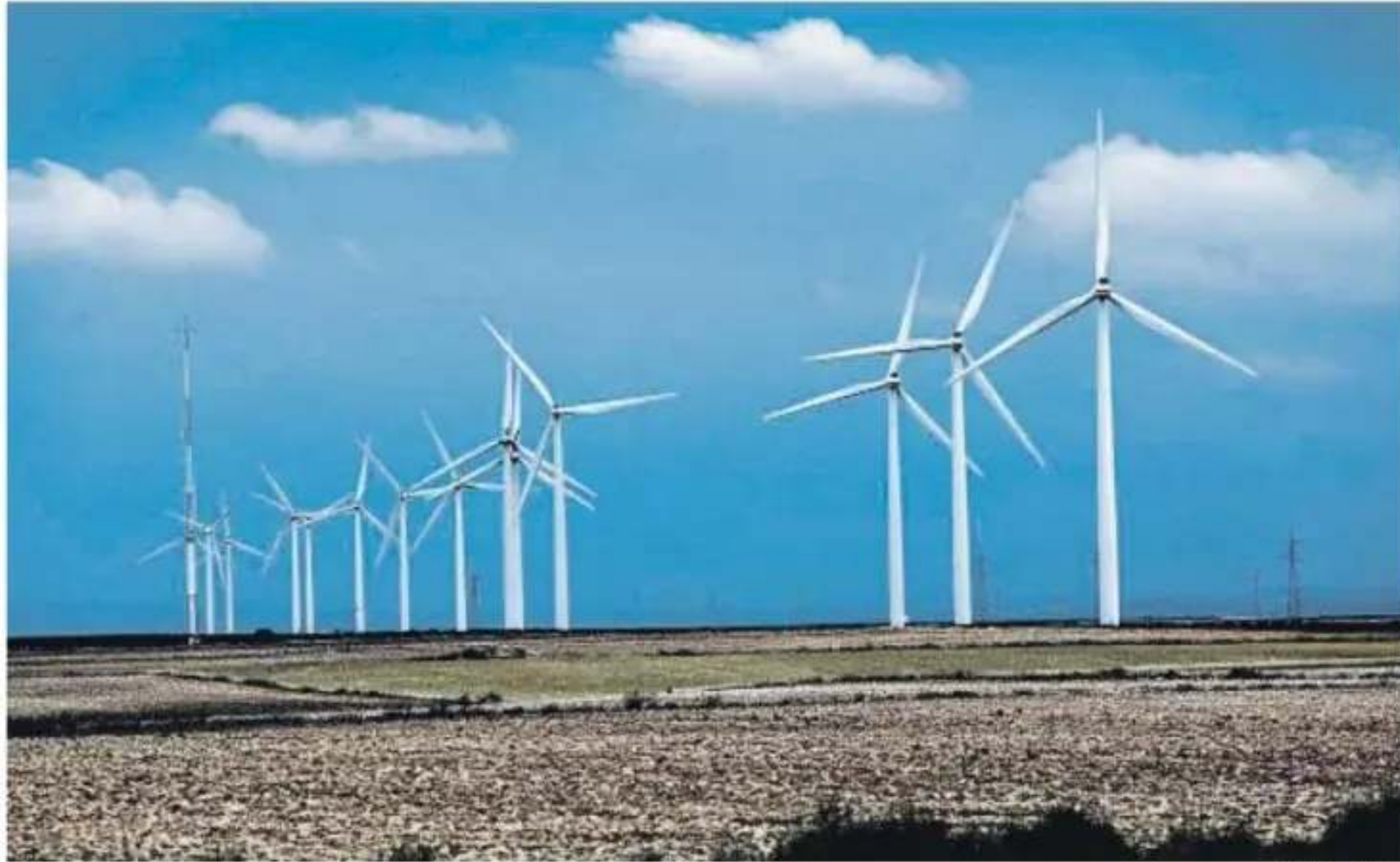
Aerogeneradores en la provincia de Huesca
